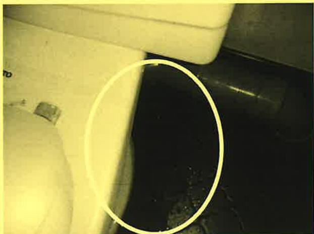
そして左の写真は、別の物件では水は流れたのですが、トイレの本体の接続部分に不具合があり、トイレのタンクと本体の隙間から漏水が確認されたケースもあります。こういった場合もあるため、水が流れても周辺が水漏れがしていないかチェックする必要があります。
